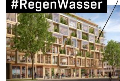
Sowohl die Dach- als auch die Fassadenbegrünung werden an trockenen Tagen durch das in der Zisterne gespeicherte Regenwasser versorgt. Durch eine automatisierte Wasserregulierung kann der Pflegeaufwand reduziert werden. Das überschüssige Regenwasser wird über eine Rigole ins Grundwasser geleitet und trägt so trotz des hohen Versiegelungsgrades zum Konzept der **Schwammstadt** bei.
